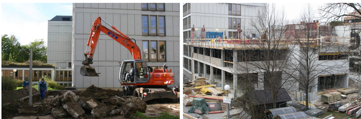
Abb. 4: Fortschrittsgrade bei der Errichtung des eb-hauses : Aushub und Rohbau
